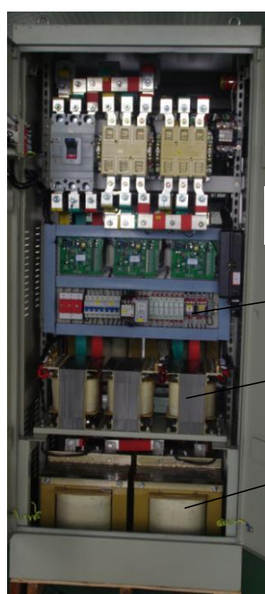
图5 内部装置结构图(正面)
